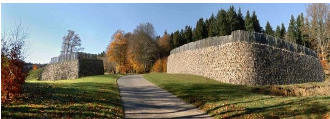
Reconstitution du murus gallicus de la porte du Rebout, Oppidum de Bibracte, Glux-en-Glenne, Nièvre
